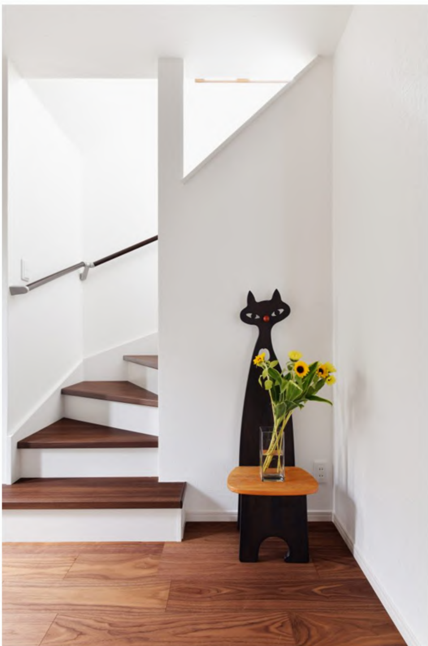
階段：壁上部に開口を作り、光を取り込めるように工夫しました
